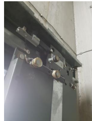
Serrure de porte palière du niveau principal
